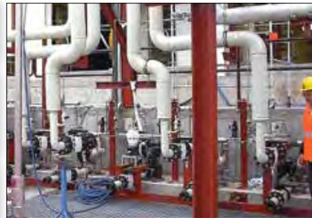
Pompes à membrane en acier inoxydable 2" (50,80 mm) assemblées avec des antipulsateurs en PVDF, utilisées pour pomper de l'acide fluorhydrique
