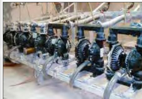
Pompes à membrane 3" (76,20 mm) montées sur un châssis, permettant de transférer de l'argile dans une usine de fabrication de céramique
